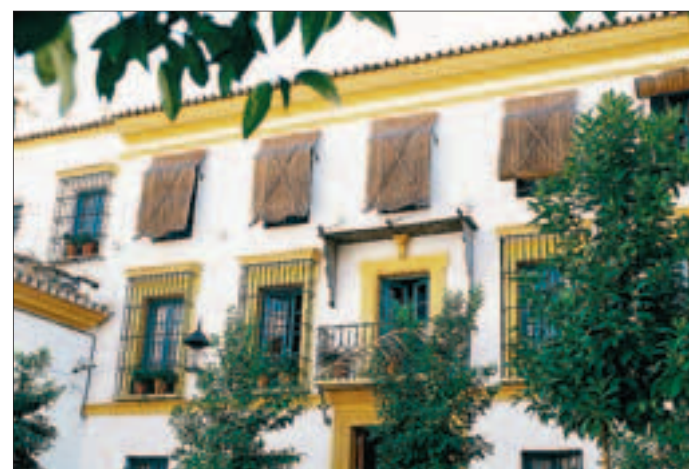
UN ESPACIO SINGULAR Fachada del hotel Hospes Las Casas del Rey de Baeza (cuatro estrellas), ubicado en pleno centro de Sevilla. Ofrece 42 estancias de primer nivel.
