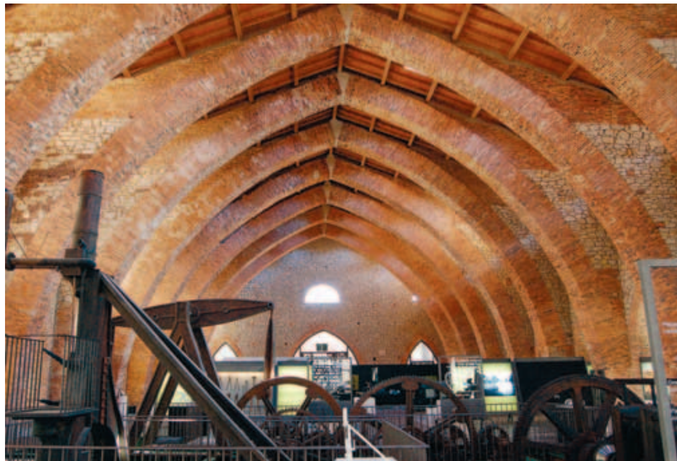
Vista general de la nave central de la Ferrería, con reproducciones a tamaño real de la maquinaria.
