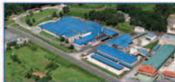
Fábrica en Caldas (Pontevedra).
